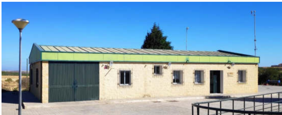
Fotografía n° 3.- Edificio de oficinas y telecontrol.
